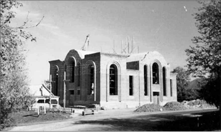
Іл. 4. Стан будівництва храму в 1999 р.
