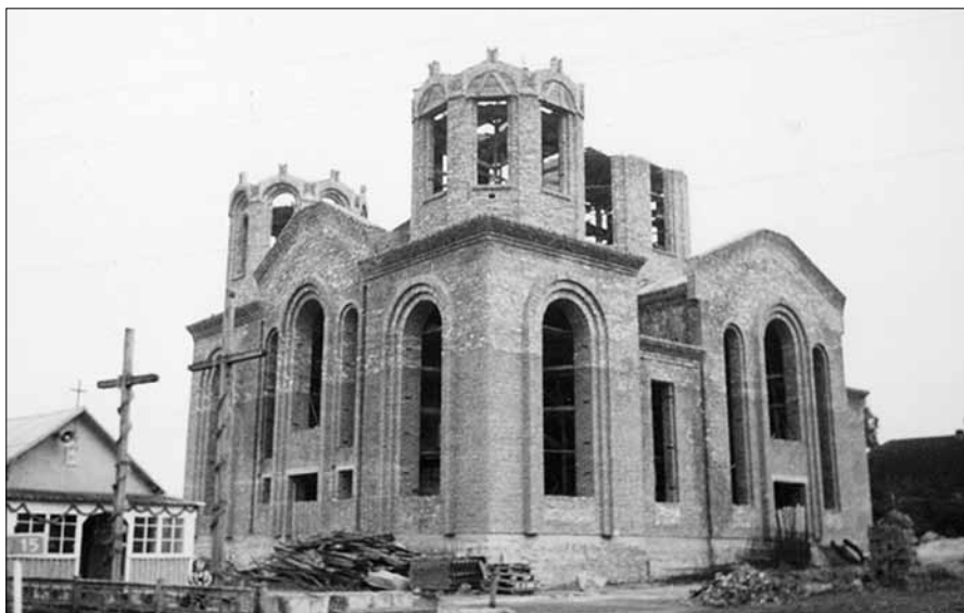
Іл. 5. Стан храмової будівлі у 2001 р.
