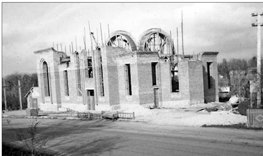
Іл. 3. Стан будівництва храму в 1998 р.
