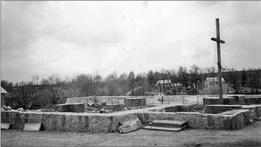
Іл. 2. Будівництво церковного фундаменту (1995–1996 рр.)
